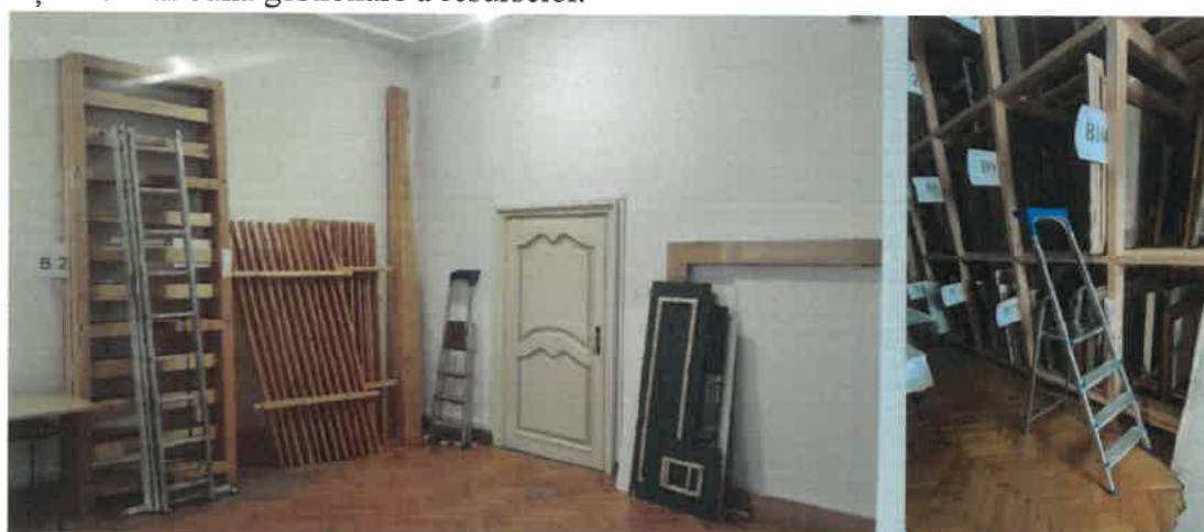
Înainte și după demontarea rafturilor vechi, din lemn
